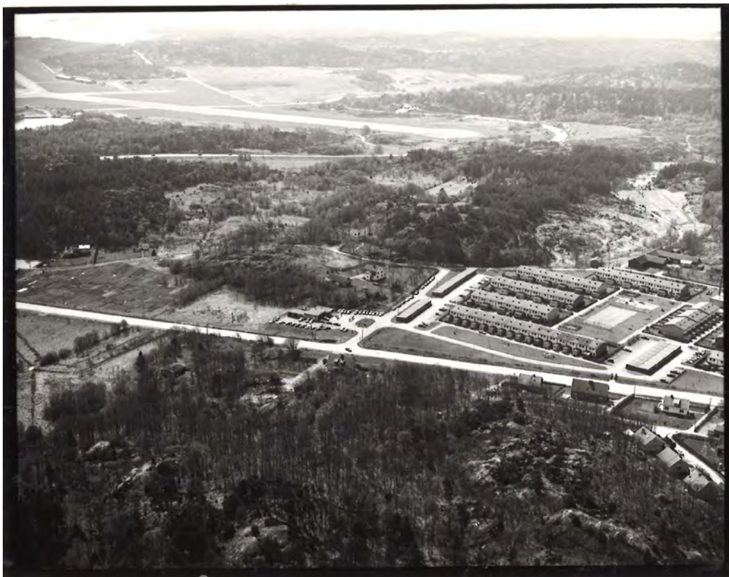
Figur 12. Flygfoto från 1976 mot väster med Kongahällavägen i mitten. Fotot ger en bild av den lägre terrängen kring bergsimpedimenten vid vilka flera fornlämningar är belägna. Foto: Lars Noord
