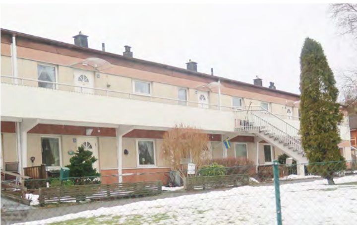
Figur 59. Långloftshus med de synliga betongkonsolerna och de snedställda trapporna.
